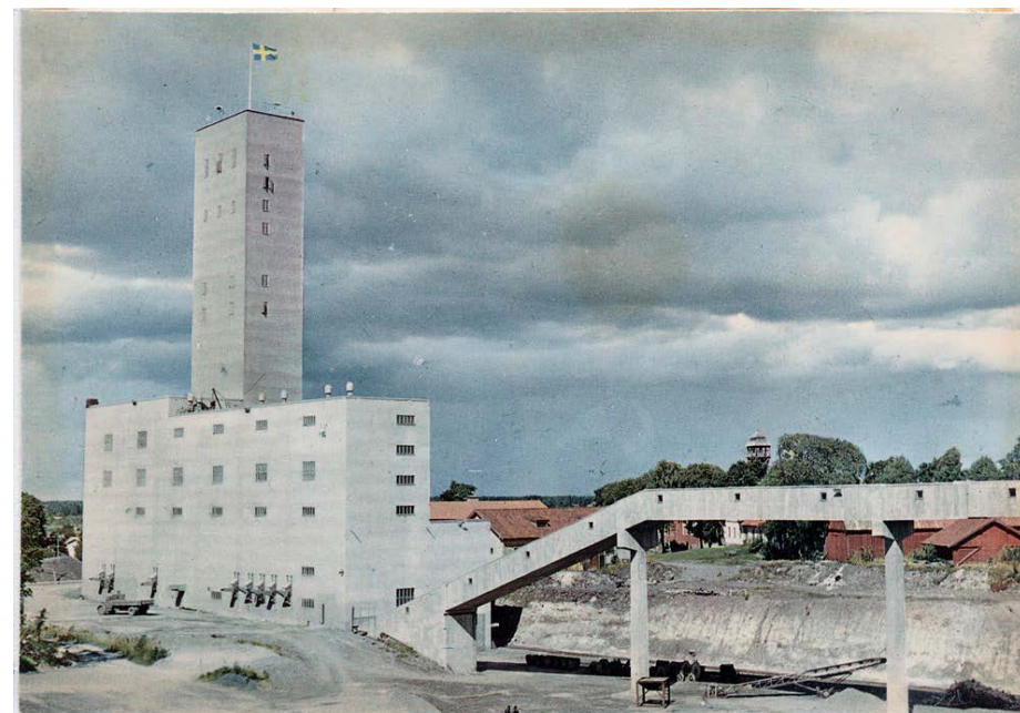
Den mest monumentala byggnaden i Dannemora är gruvlaven i betong från 1950-talet.
