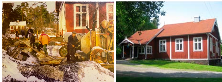
Till vänster: Gjutning av plattan till nya entrén och köket. Svante, Birger, Fritz och Kalle jobbar på. Till höger: Bygdegården idag.
