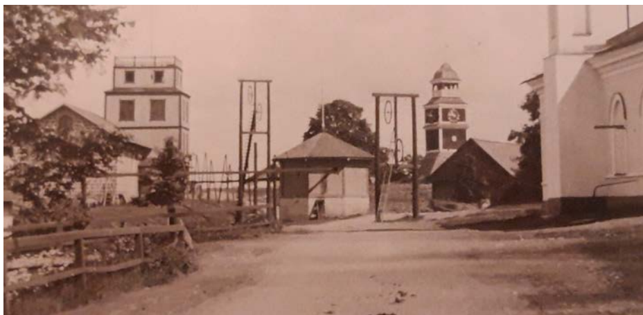
Vändbrottet på ursprunglig plats i Dannemora. Okänd fotograf början av 1900-talet? Foto från Hembygdsgården.
