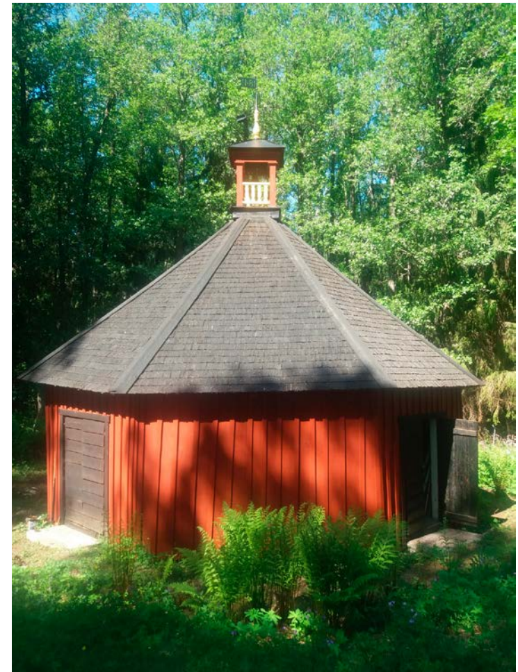
Det nyrenoverade Brunns huset i Dannemora.
